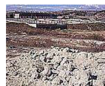
Am905 - Infrastrutture del mercato comunale in costruzione
