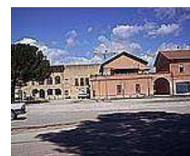
At913 - Piazzale Via degli Achei
