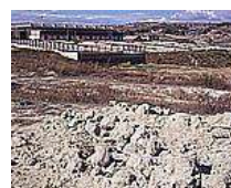
Am905 - Infrastrutture del mercato comunale in costruzione
