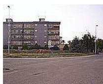
At721 - Via Andrea Ferrari - traversa di Via Pirandello
