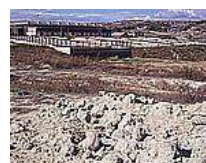
Am905 - Infrastrutture del mercato comunale in costruzione
